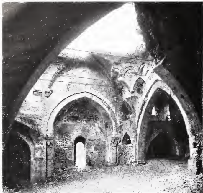
Fig. 10. - MESSINA - Chiesa di S. Maria alla Scala. Veduta interna della tribuna maggiore e della cupola.
